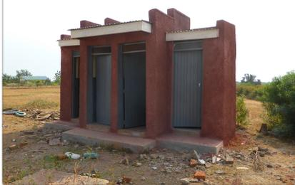
Dans chaque bâtiment, la toiture a été refaite, les fenêtres et portes changées, les murs réparés et la peinture posée.
